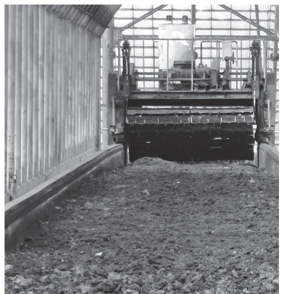
生ごみの有機肥料化プラント（幅4m全長100m）
