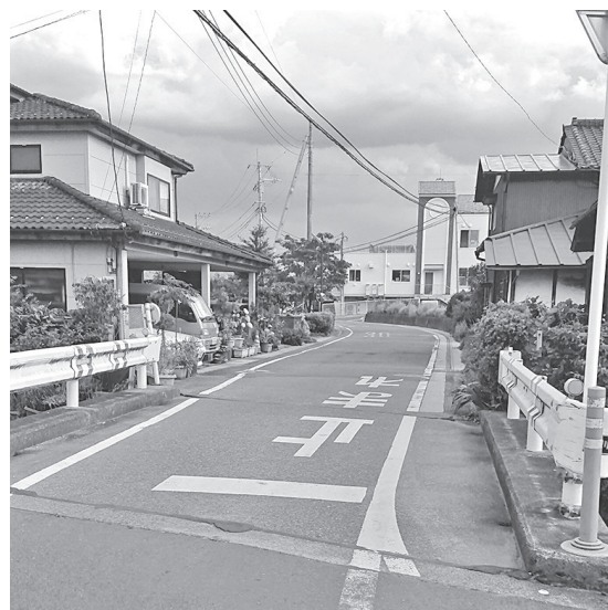
幅の狭い通学路の拡幅が必要 (第二保育園北の唐川橋)
