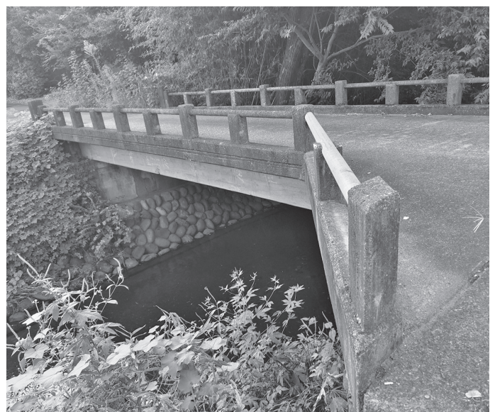
供用開始から65年経過した御所橋
