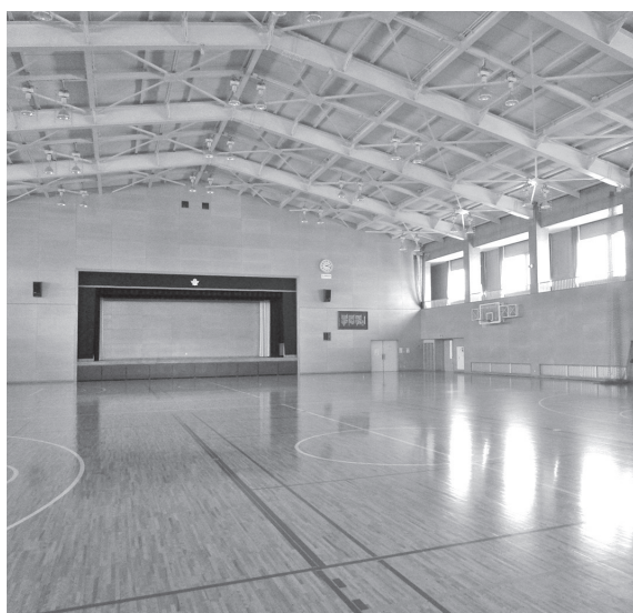
移動可能な空調設備があれば、バレーボール大会でも使用できる（吉中体育館）
