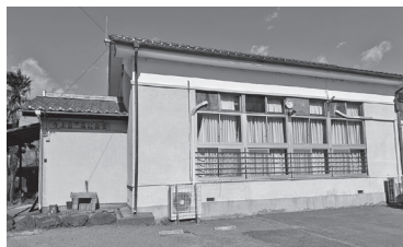
整備が求められる指定避難所 (三津屋田端公会堂)
