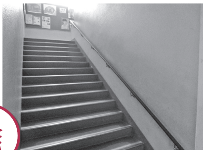
改修された駒小南校舎階段手すり
